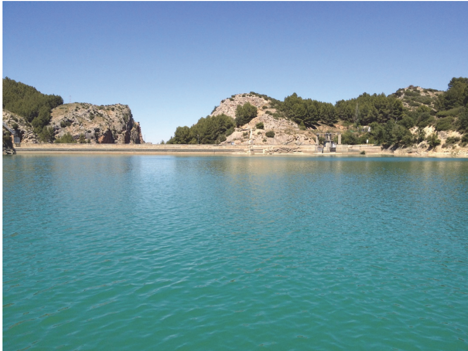
Figura 7. Vista de la presa del embalse
