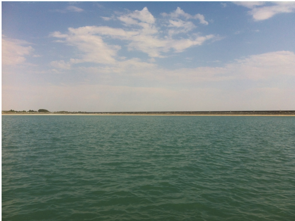
Figura 7. Vista de la presa del embalse
