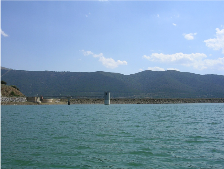
Figura 7. Vista de la presa del embalse.
