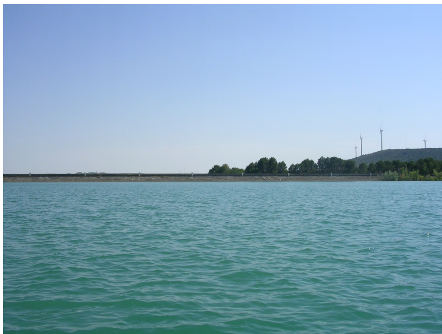
Figura 7. Vista de la presa del embalse
