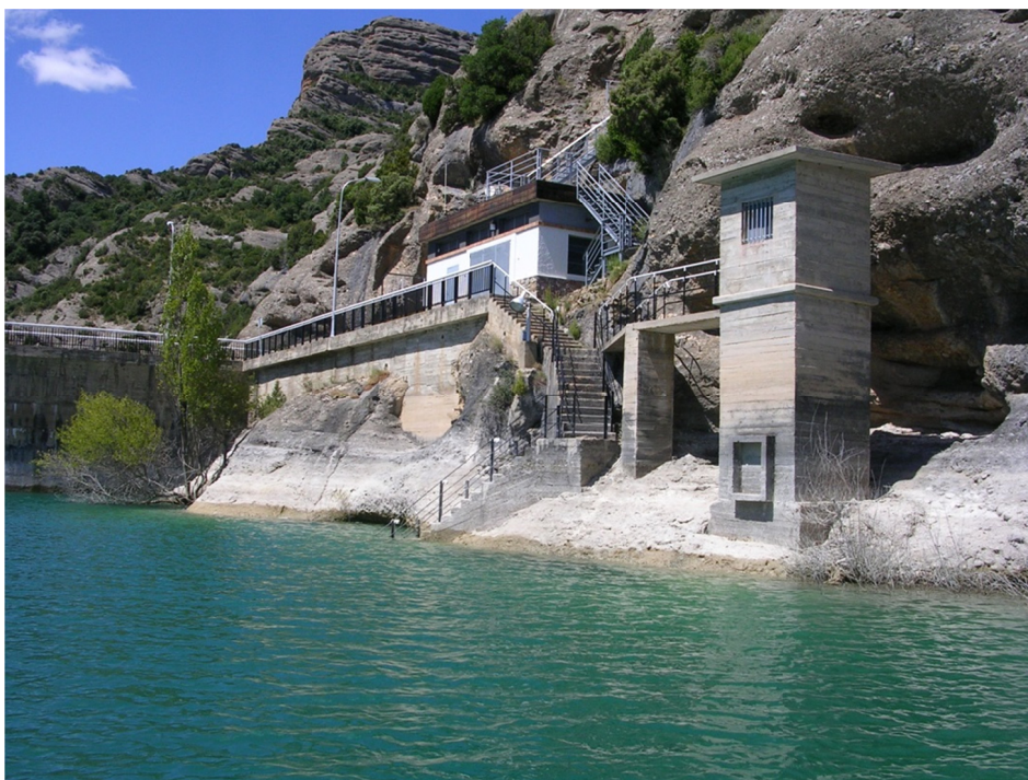
Figura 8. Vista del punto de acceso.
