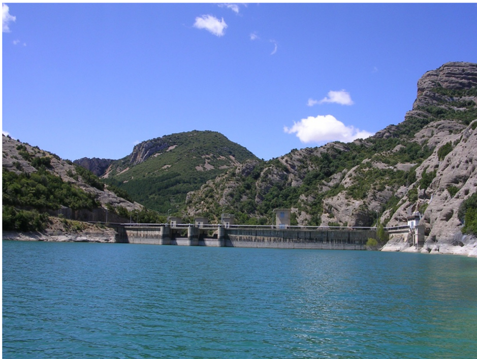
Figura 7. Vista de la presa del embalse.
