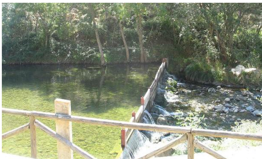
Figura 19-19. Pequeña represa en el cauce alto del río Urbión.
