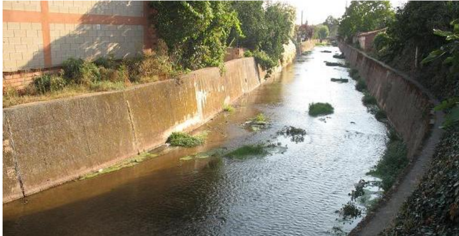
Figura 19-31. Canalización en la localidad de Uruñuela.
