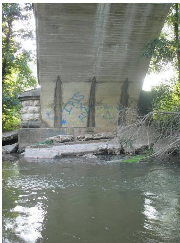
Figura 19-15. Cauce del río Najerilla a su paso bajo la N-232.
