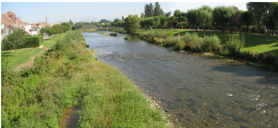
Figura 19-12. Canalización del río Najerilla en Nájera.
