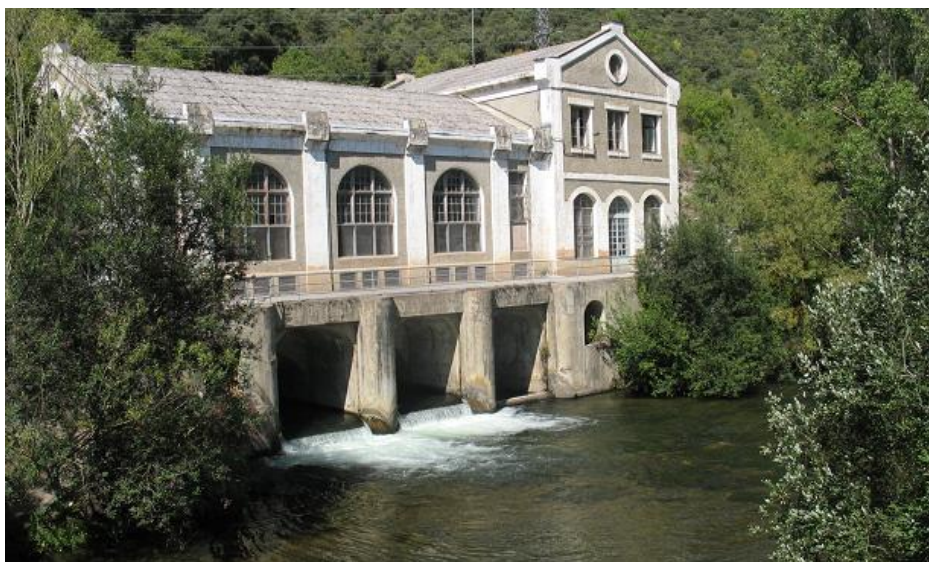
Figura 19-6. Central hidroeléctrica de Anguiano.
