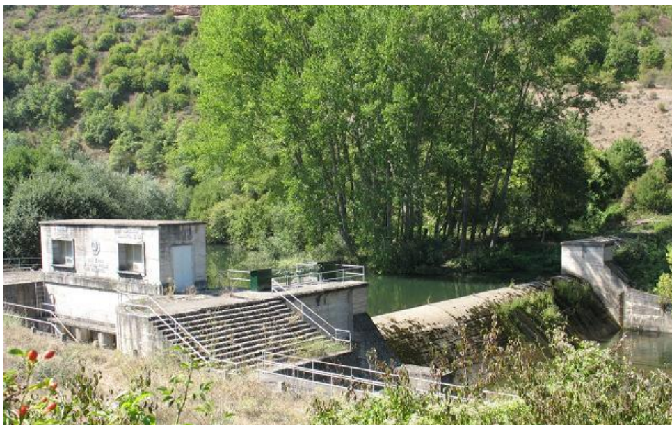
Figura 19-9. Derivación hacia el canal de la margen izquierda del Najerilla.
