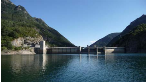
Foto 1: Presa del embalse de Búbal.
