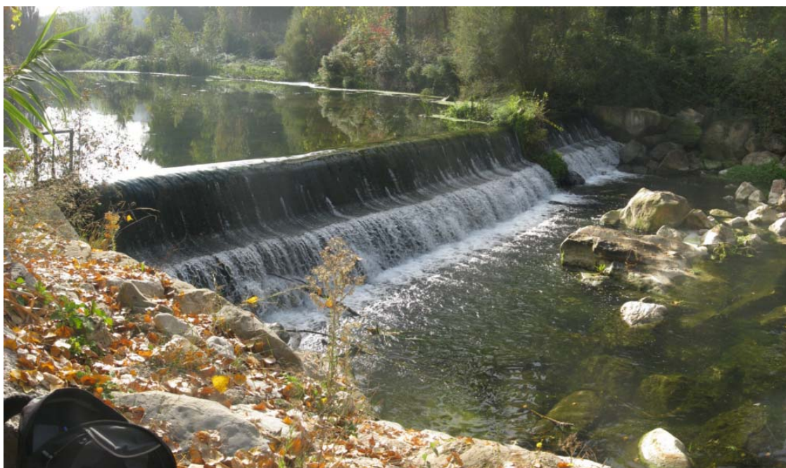
Fig. 6. Vista de la estructura desde la margen derecha del río Matarraña.
