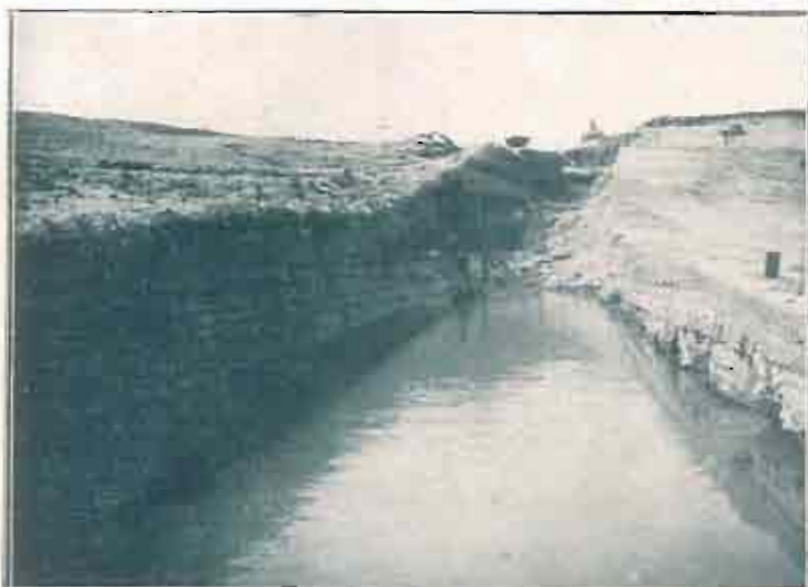
TORMOS: CANTAS EN LA PRESA DE "VACIAS", CON AGUAS PROCEDENTES DE LLUVIA
