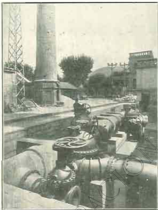
Colector de un metro, con empalmes para presión de 12 Kg./cm 2
