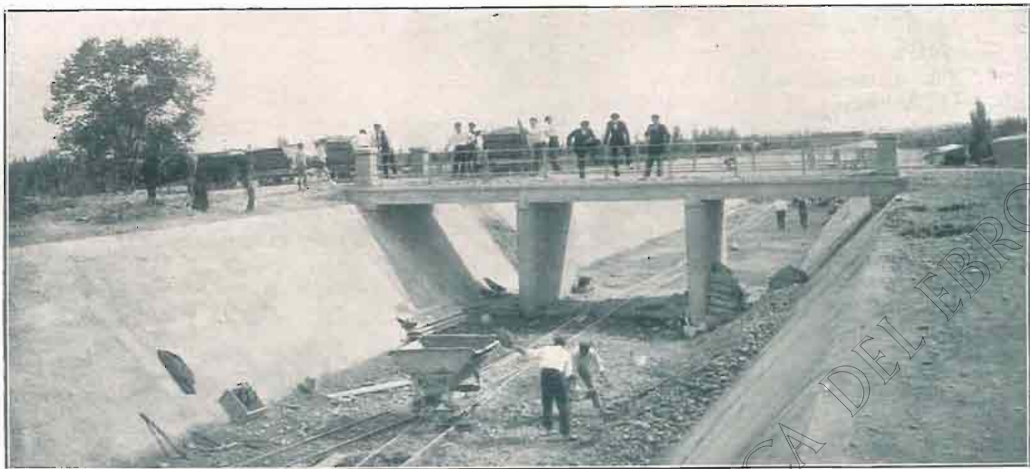
CANAL VICTORIA-ALFONSO: PUENTE EN EL CAMINO DE "LA QUERRA"
