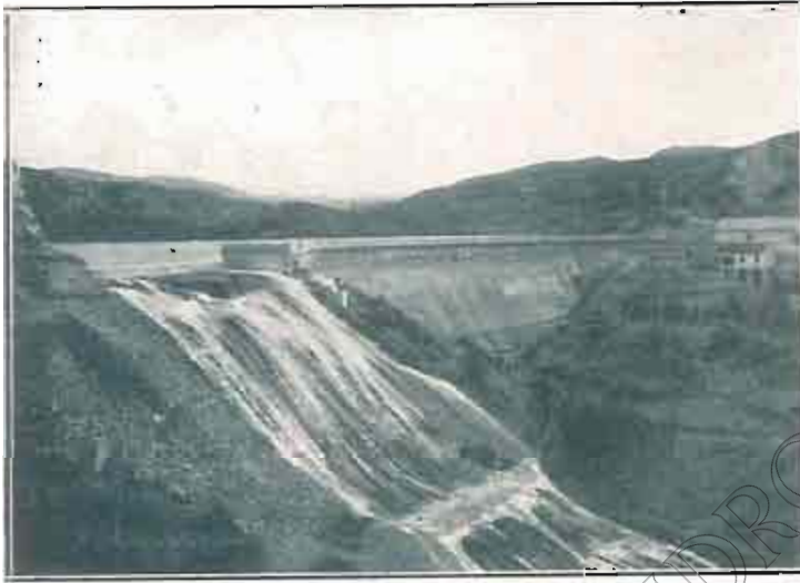
PANTANO DE GALLIPUÉN: EL ALIVIADERO DE SUPERFICIE
