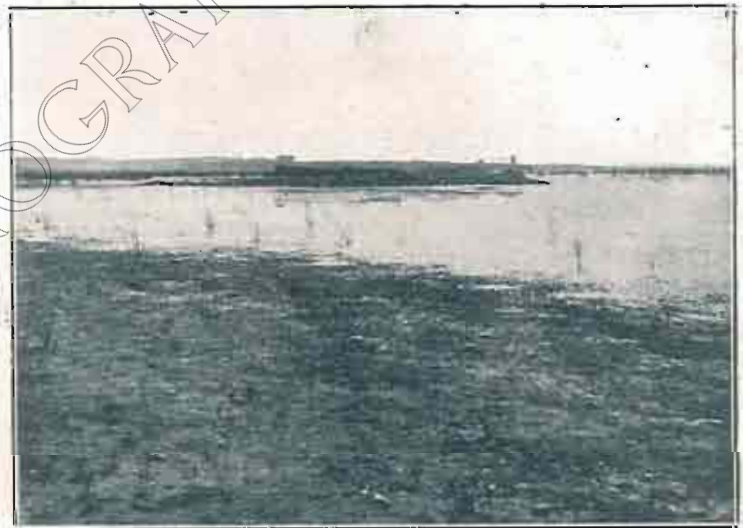
TORNOS: ASPECTO DEL EMBALSE DE LA SOTONERA, AL FONDO SE DIVISA LA TORRE DE COMPUERTAS
