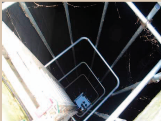
Figura 12. Acceso al foso de bombeo.
