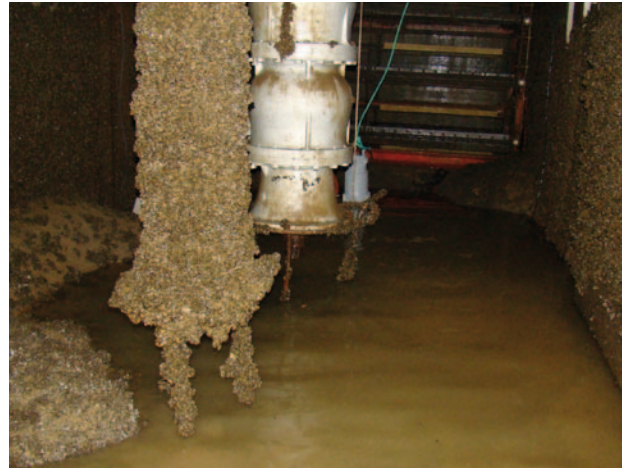
Figura 5. Bomba tratada con pintura antiincrustante (derecha) y bomba no tratada (izquierda). Fuente: Nuclenor (Burgos).
