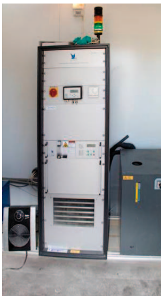
Figura 24. Generador de ozono. Para su óptimo funcionamiento debe alojarse en una ubicación climatizada.
