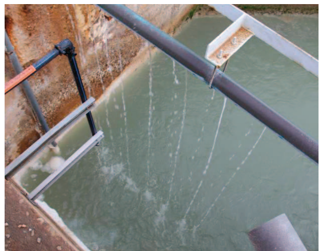
Figura 23. Dosificación conjunta del sulfato de aluminio y el hipoclorito sódico.
