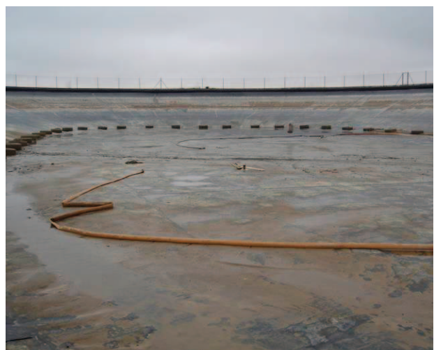
Figura 15. Balsa de acumulación o regulación.
