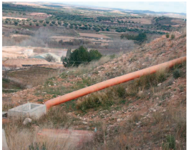
Figura 14. Tubería impulsora.
