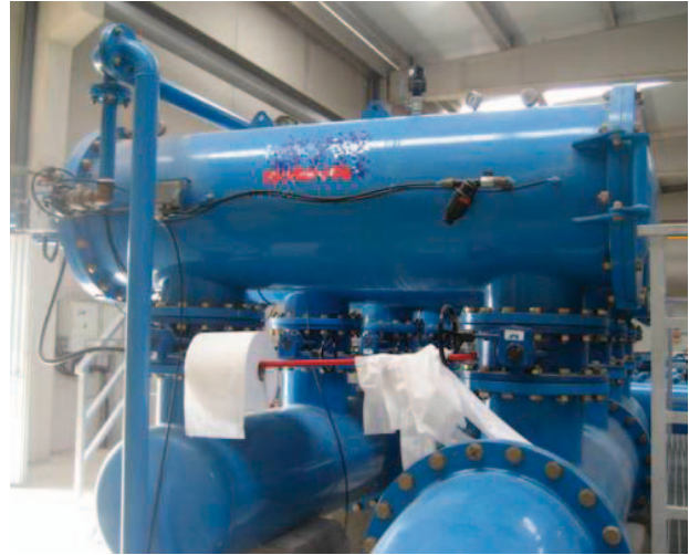
Figura 26. Instalación de filtrado.
