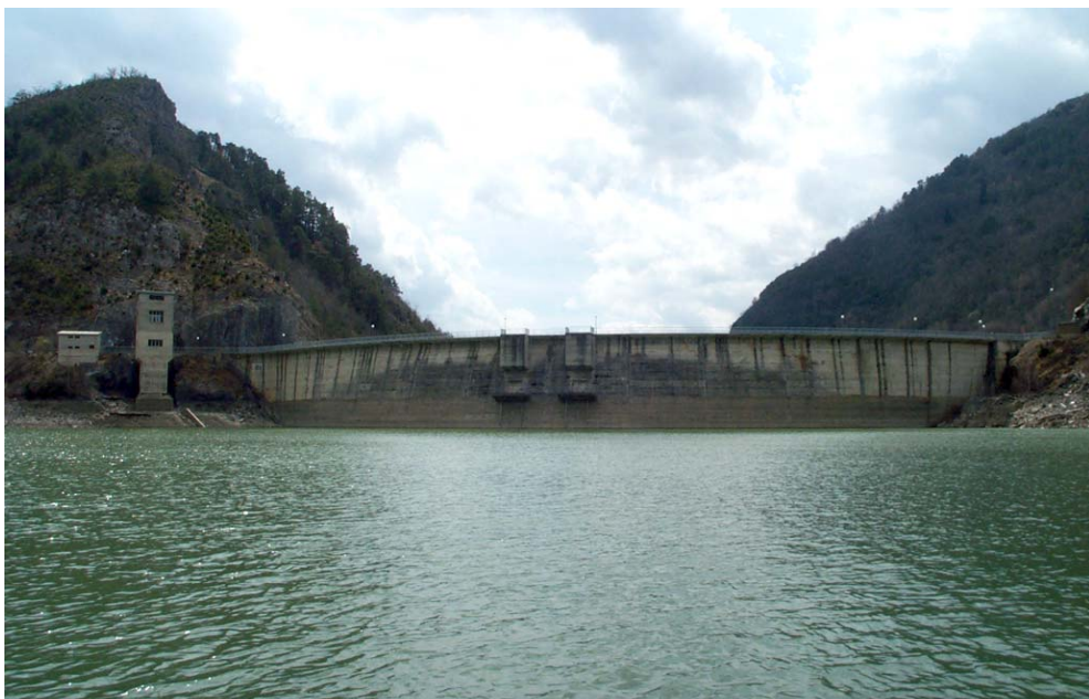
Detalle de la presa. Primavera de 2005 (07/04/2005)
