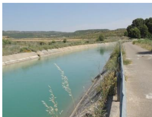
Canal de Bardenas en el punto dónde cruza el barranco de La Portillada
