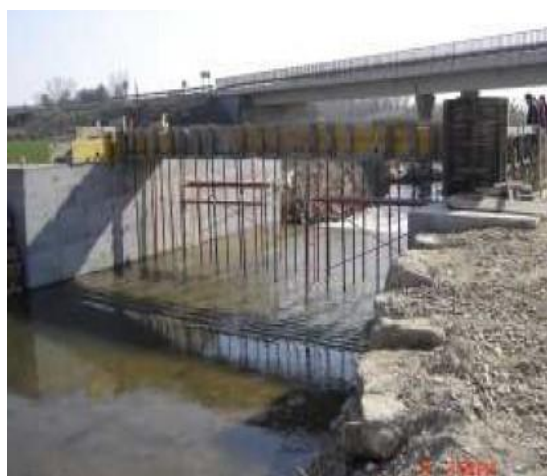
Estación de aforos en construcción
